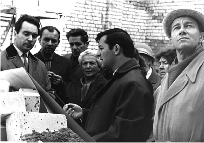
Михаил Лазарев (крайний справа) на строительстве Дома Актера. 1972
